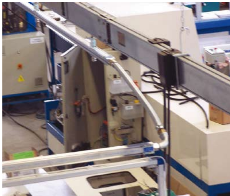
La ceinture principale est constituée du système HBS (diamètre 32 mm), tandis que c'est la canalisation AP 25 (25 mm) qui a été retenue pour réaliser les alimentations des machines.
