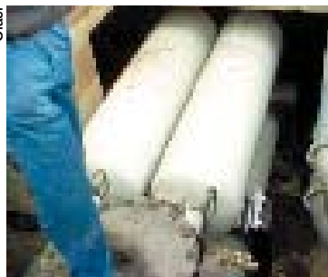
Requalification d'accumulateurs à piston montés en batterie horizontalement
