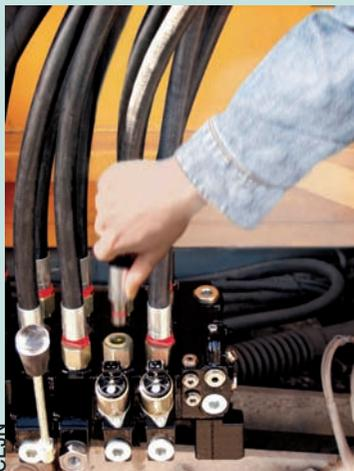
Destinés à remplacer les raccords hydrauliques à visser, les raccords encliquetables Weo du suédois CEJN se connectent comme une prise de courant. Ils ne fuient pas et offrent une rapidité d'assemblage qui réduit considérablement les arrêts de production lors du montage et lors de la maintenance sur site puisque seul un simple tournevis suffit à les déconnecter. Pour les engins de travaux publics, CEJN sort une
