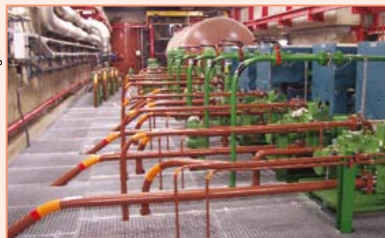
Salle des pompes
