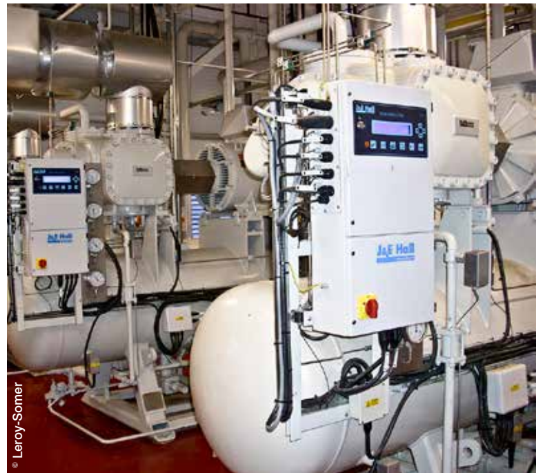
Le Dyneo de Leroy-Somer est notamment installé dans la salle des machines du fabricant d'équipements frigorifiques J&E Hall.
