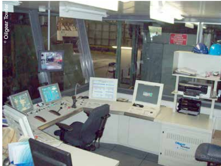
Sur cette installation réalisée par Oilgear Towler, les utilisateurs suivent les informations en temps réel rafraîchies en quelques microsecondes.
