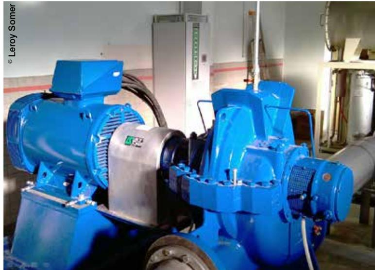
Leroy-Somer a remplacé les deux moteurs par un unique moteur synchrone à aimants permanents PLSRPM 315 de puissance 350 kW avec une vitesse de rotation de 1500 tours/min, commandé par un variateur Powerdrive MDS 470T pour gérer au mieux les régimes variables
