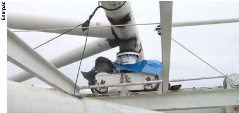
44 chariots se déplacent sur des rails et soutiennent la toiture mobile du stade de Nantong.
