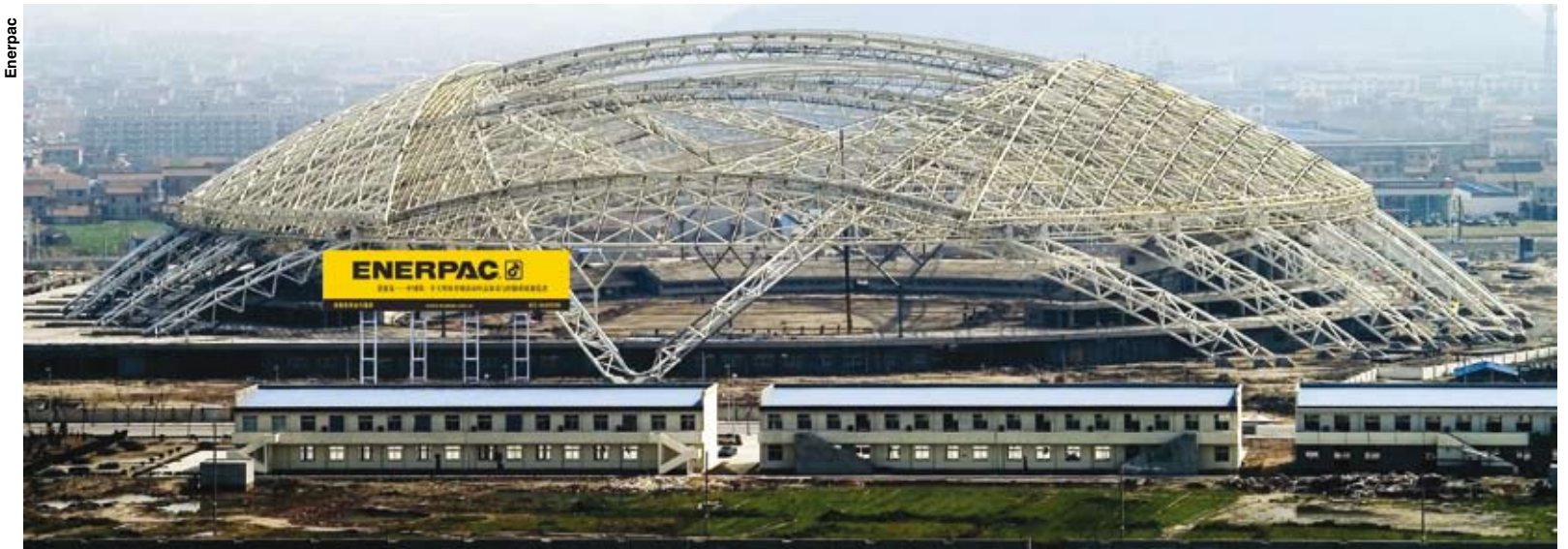
L'hydraulique Enerpac veille à ce que les opérations d'ouverture ou de fermeture de la toiture du stade de Nantong soient réalisées de manière sûre et contrôlée en moins de 30 minutes.
