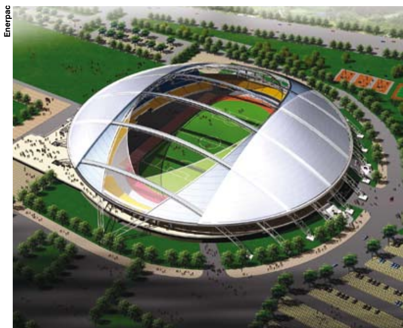
2200 tonnes d'acier composent le toit mobile du stade de Nantong.
