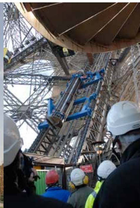
Bosch Rexroth a contribué à la modernisation des ascenseurs de la Tour Eiffel en rénovant leur motorisation hydraulique.
