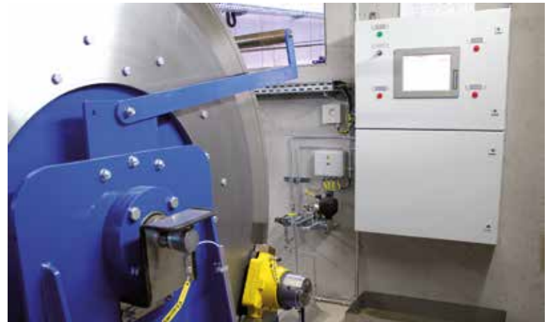
Etriers de frein hydraulique et système de contrôle de freinage BCS 600 de Ringspann pour contrôler la montée et la descente d'un funiculaire.
