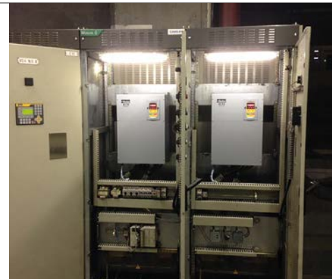
Variateurs AC10 intégrés dans les armoires du parking
