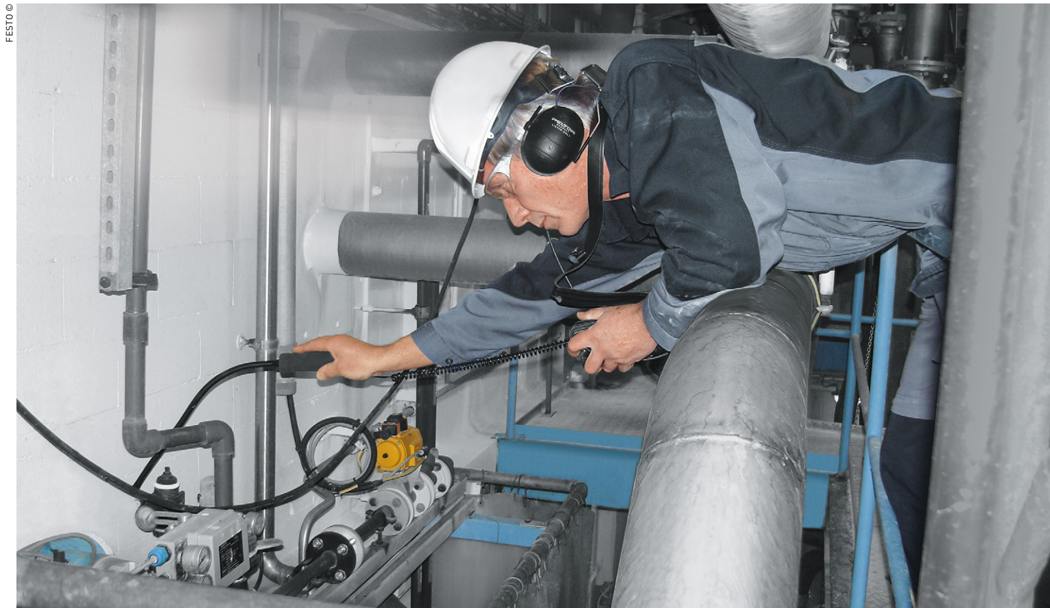
Détection de fuites par Festo à l'usine de Koog Aan de Zann de Tate & Lyle, qui représentaient près de 8% des coûts globaux en air comprimé.
